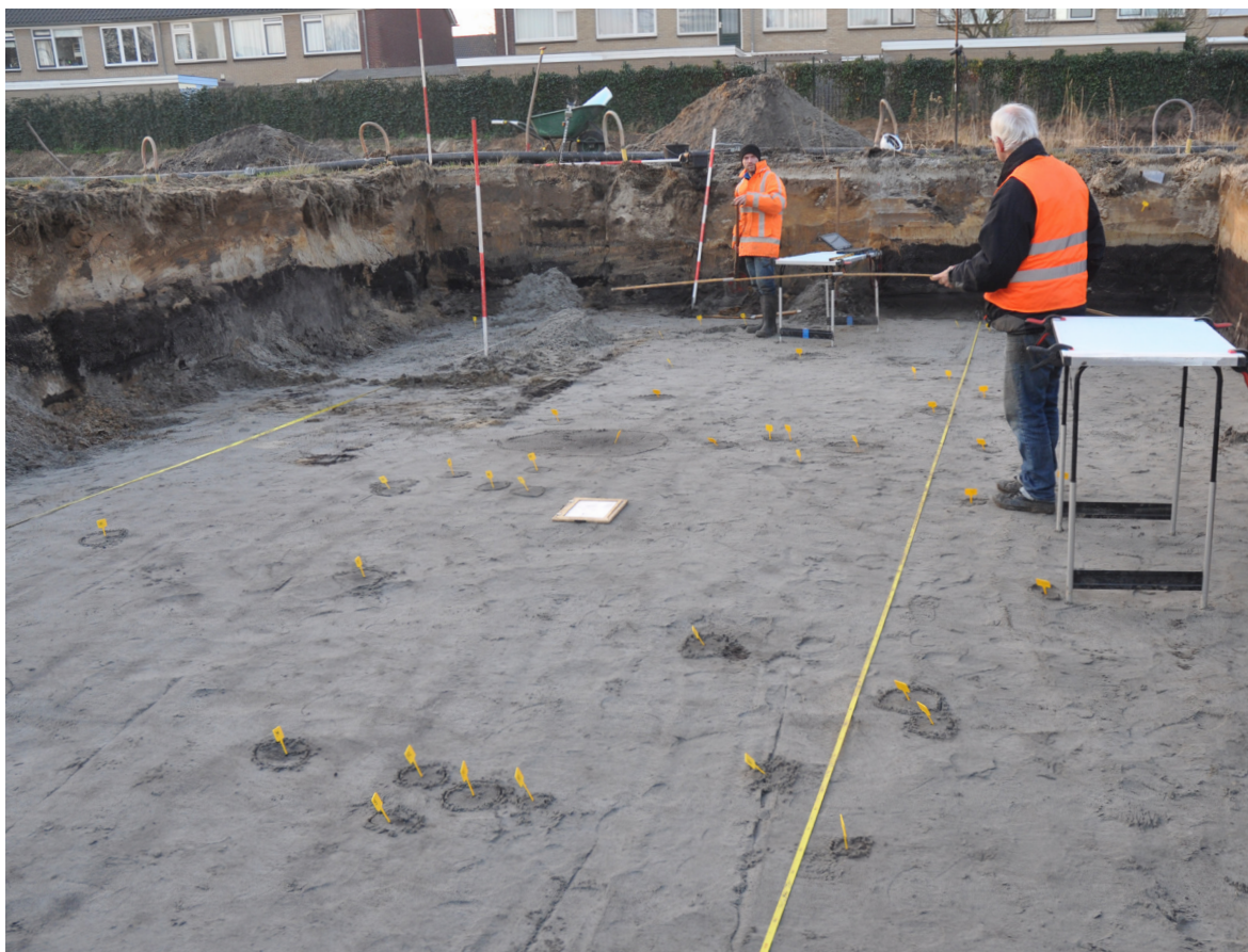
Boven en onder: het vlak met de paalkuilen van een gebouw uit circa 1950 v. Chr.
